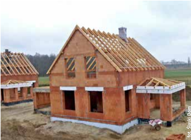
BUDOWA OSIEDLA – ściany zbudowano z pustaków ceramicznych, a więźbę dachową z wysokiej jakości drewna
