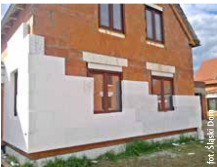
OCIEPLANIE ŚCIAN STYROPIANEM – nadproża okien i drzwi zostały specjalnie docieplone dla uniknięcia mostków termicznych
