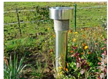
CZERPNIĄ POWIETRZA systemu wentylacji mechanicznej z rekuperacją i gruntowym wymiennikiem ciepła
