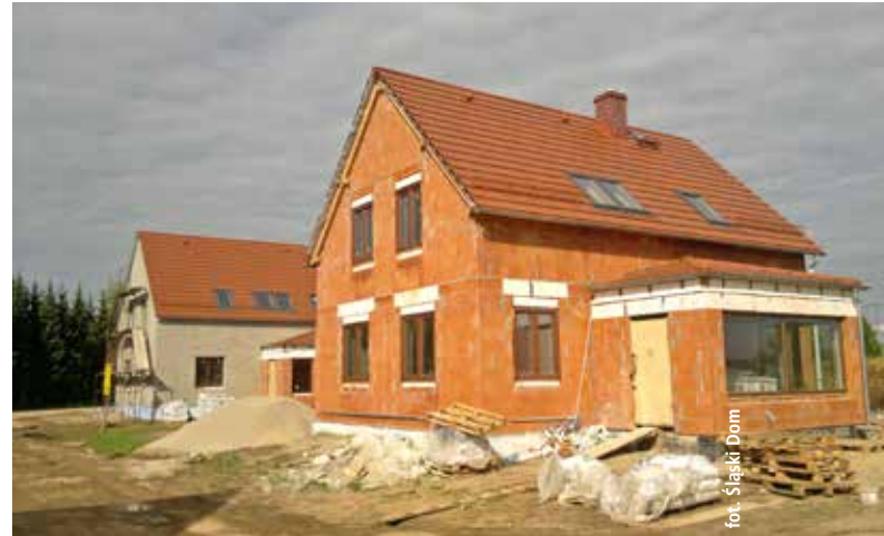
JAKIŚ CZAS PÓŹNIEJ – dach już przykryty dachówką ceramiczną, okna i tymczasowe drzwi wstawione. Dom w głębi jest już tynkowany
