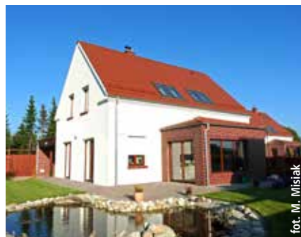
OGRODOWE ELEWACJE DOMU – widoczne są drzwi tarasowe prowadzące na opasujący dom od tyłu taras oraz okna dachowe doświetlające poddasze
